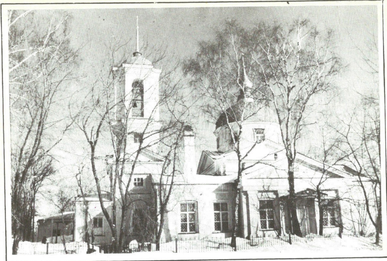
Церковь Космы и Дамиана — старейшее из сохранившихся архитектурных сооружений города
