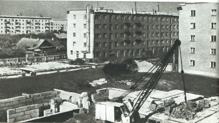
Строительство новых домов на ул. М. Горького.
