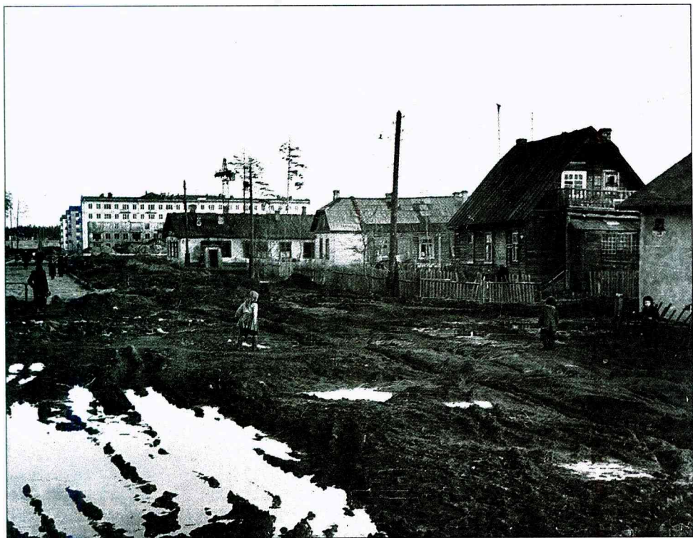
Строительство нового жилого района (калининградские "Черемушки") в начале 1960-х гг. Фото И. Машкова
