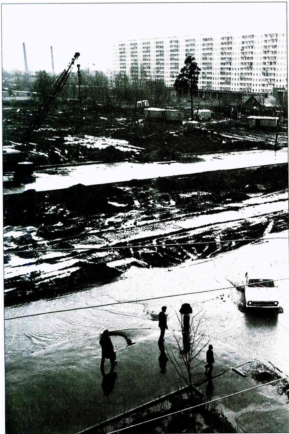
Строительство проспекта Королева. Фото Р. Рубцова. 1973 г.
